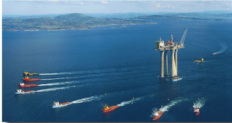
Der „Troll“ wird an die richtige Position gebracht...
